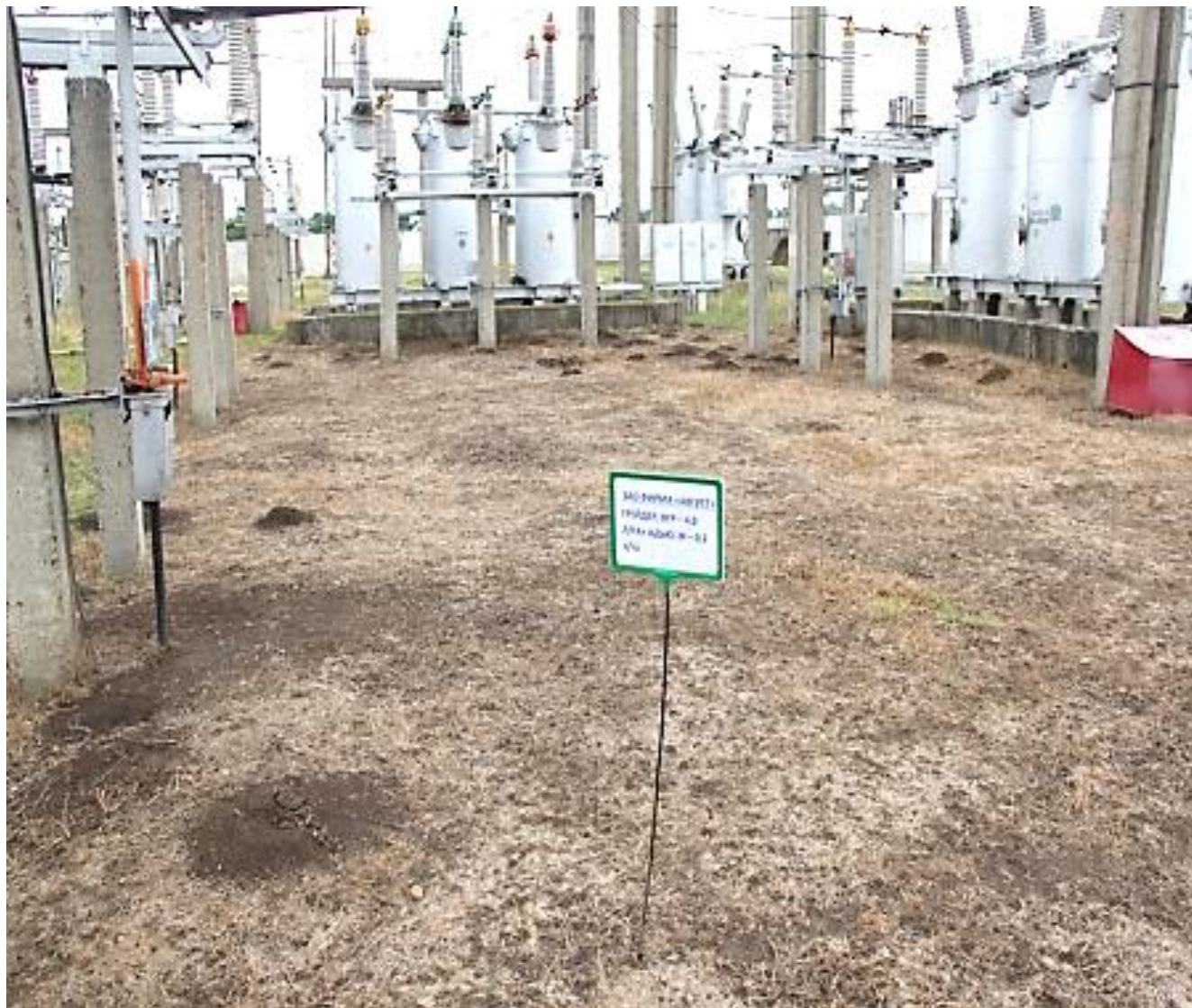
Фото 2. Эффективность баковой смеси гербицидов Грейдер (4,0 л/га) + Адью (0,2 л/га), подстанция «Тбилисская», Усть – Лабинские электрические сети, ОАО «Кубаньэнерго», Краснодарский край 2013г.
