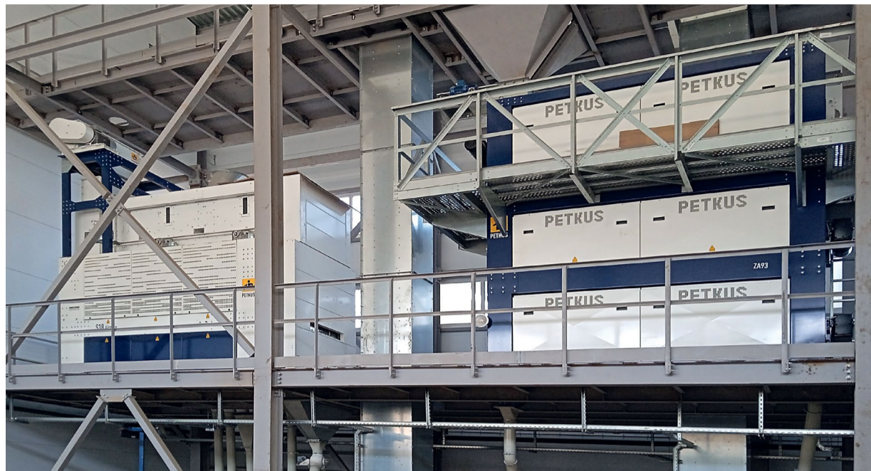
Монтаж оборудования на семенном заводе
